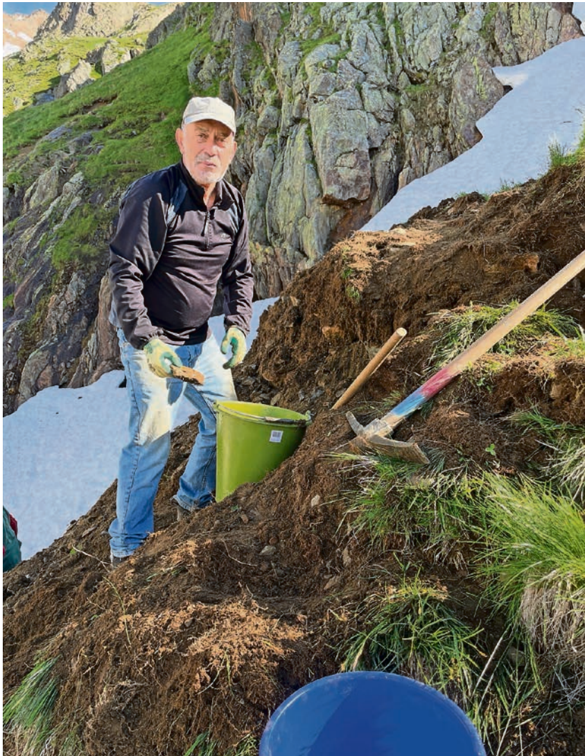
Ein Freiwilliger gräbt den Abfall im steilen Gelände Stück für Stück aus der Erde, sortiert ihn und schleppt ihn zu den Bigbag-Säcken. Der SAC Aarau hat die ehemalige Abfallgrube der Chelenalphütte saniert und 4,2 Tonnen Abfall herausgeholt. FOTOS: ZVG
